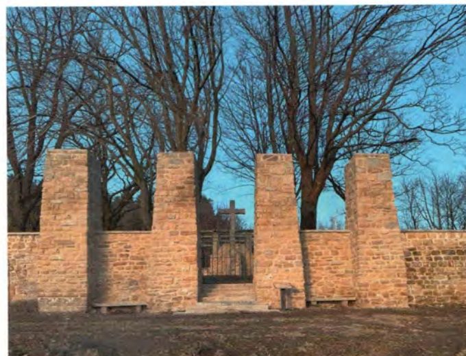
Eingangsbereich des generalsanierten Kriegerfriedhofes Nr. 80 im Jahr 2023
