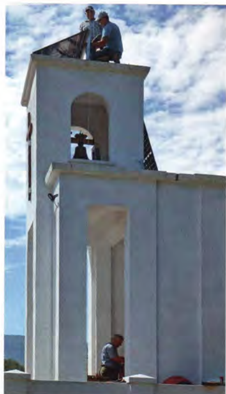
Montage der Photovoltaik-Anlage auf dem Dach des Glockentürmchens
