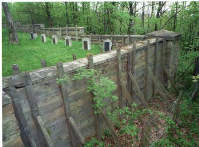
Abstützung der schwer beschädigten Einfriedungsmauer des Kriegerfriedhofes Nr. 80 Sękowa im April 2021
