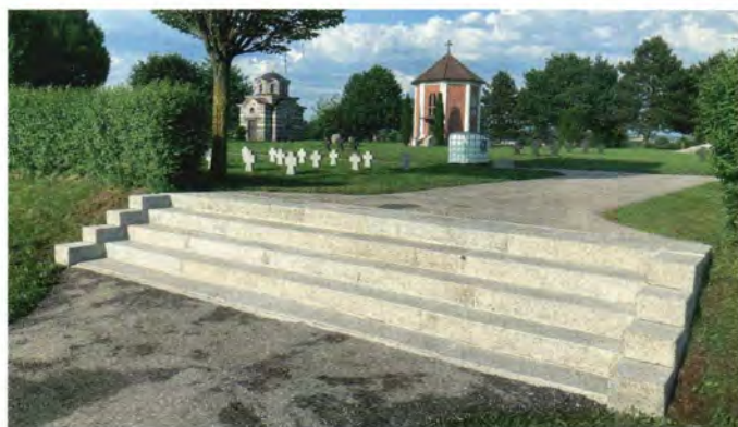
Der frisch gesäuberte Stiegenaufgang und Gehweg
