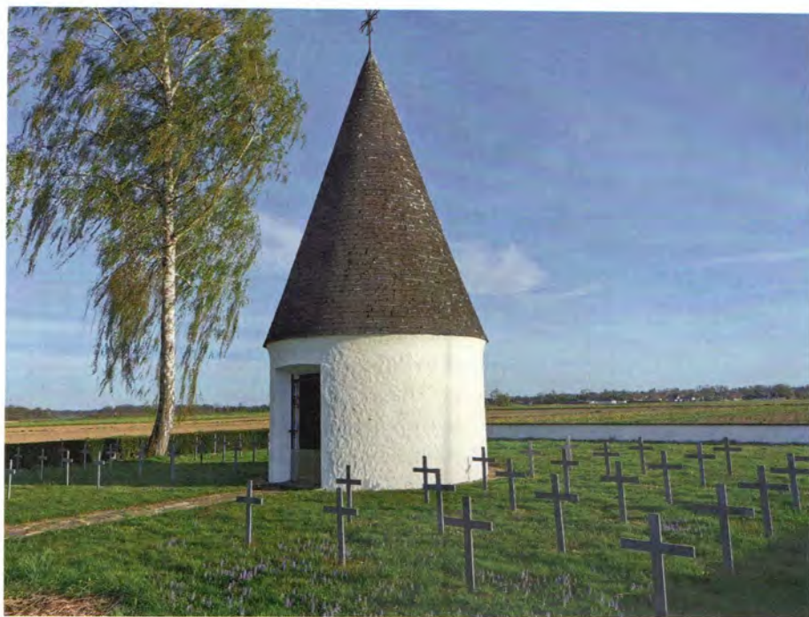
Die renovierte Kriegsgräberanlage am evangelischen Friedhof Bad Radkersburg (großes Bild)
