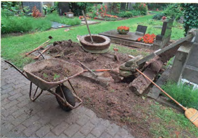
Ein Offiziersgrab vor der Generalrenovierung
