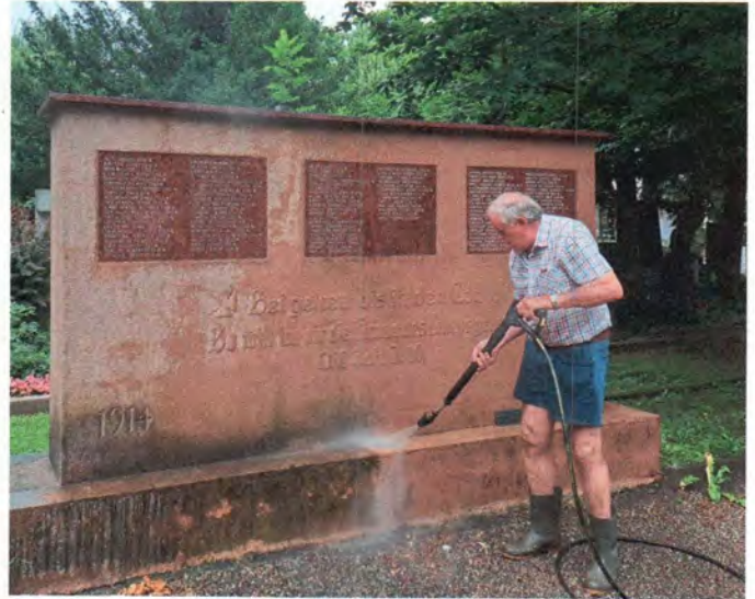
Vzlt i. R. Franz Hofer, der Chef des Arbeitseinsatzes, beim Kärchern des zentralen Denkmals
