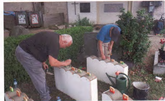
Anfertigung neuer Betonsockel, die dafür benötigten Schalungen wurden bereits vor dem Einsatz im Saarland angefertigt.
