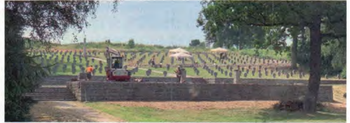
Sfdh. Freistadt-Jaunitzbachtal – Arbeiten an der Stützmauer zwischen den beiden Weltkriegsteilen
