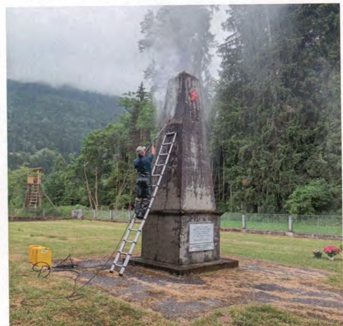
Reinigungsarbeiten am Obelisken des Russenfriedhofes Tangern
