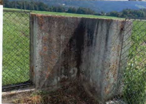
Friedhof Aich: Reinigung der Mauer, vorher (oben) – nachher (unten)
