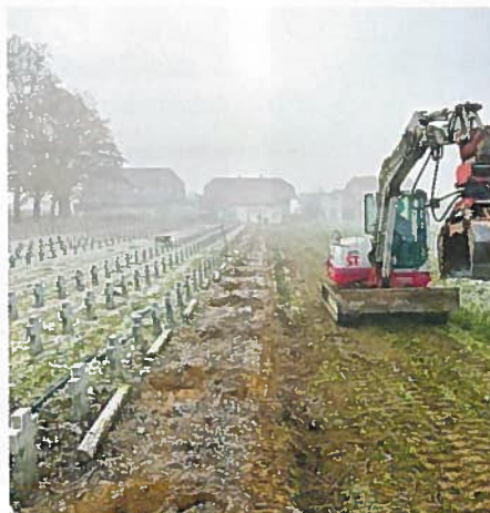
Die Entfernung der alten Hecke ist abgeschlossen.
