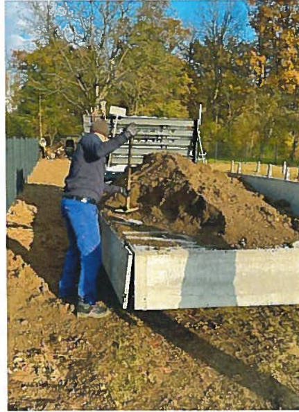
Ein Mitarbeiter der Firma Recı Zaun aus Marchtrenk bei der Arbeit
