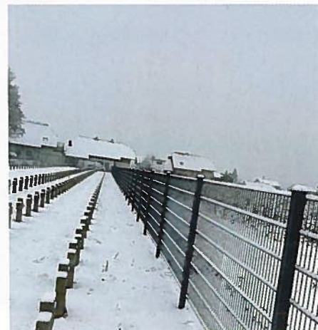
Der nun neu errichtete Doppelstabmattenzaun
