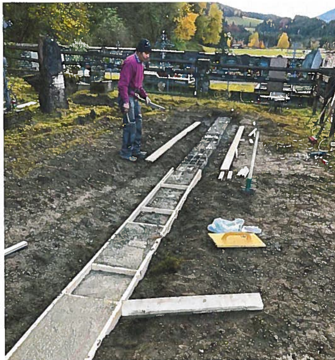
Arbeiten zum Anlegen des Streifenfundaments
