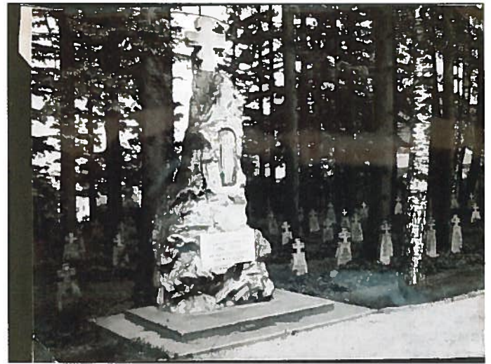
Historische Aufnahme des Lagerfriedhofes Grödig
